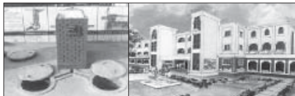
'Solution': Sulabh Twin pit pour-flush toilet
